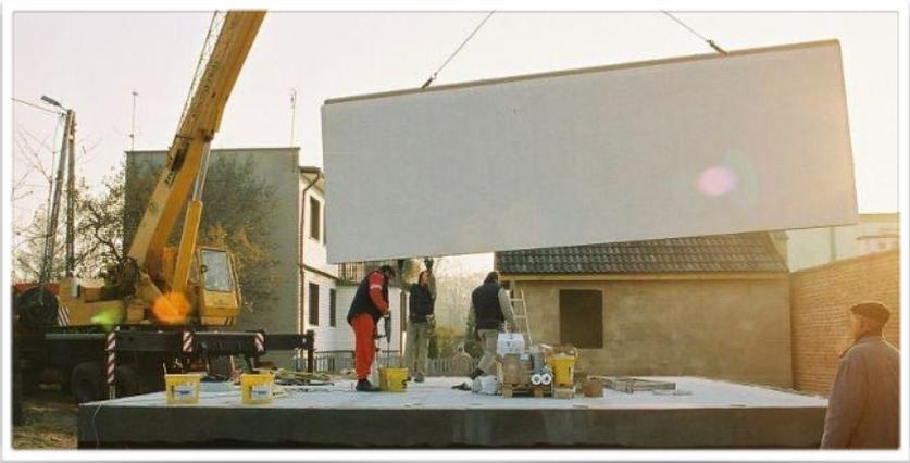
Mise en place d'une paroi préfabriquée sur le chantier
